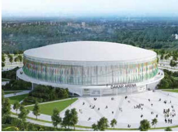
Proje İsmi : Diamniadio Sports Arena Şehir : Dakar Yatırımcı : Summa İnşaat Tarih : 2017
