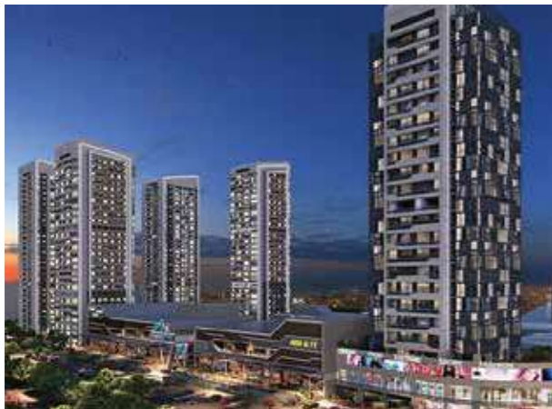
Proje İsmi : MetroMall Şehir : Ankara Yatırımcı : Söğüt İnşaat Tarih : 2016
