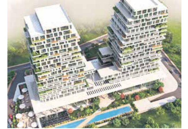
Proje İsmi : The İstanbul Veliefendi Şehir : İstanbul Yatırımcı : YDA İnşaat, Kiptaş, Kurtuluş İnşaat Tarih : 2013
