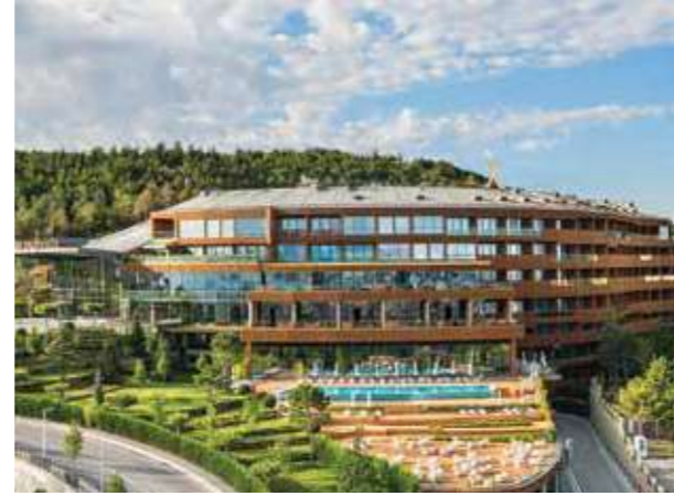
Proje İsmi : Rixos Thermal Otel Şehir : Eskişehir Yatırımcı : Polimeks İnşaat Tarih : 2013
